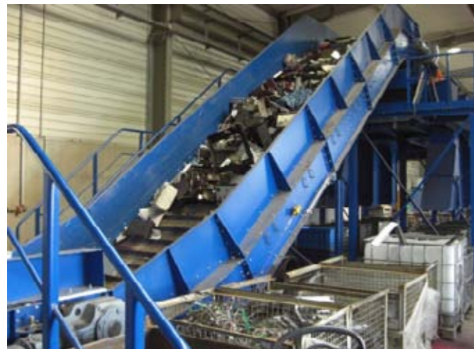
Abbildung 3: Aufbereitung von EAG im Entsorgungsbetrieb
